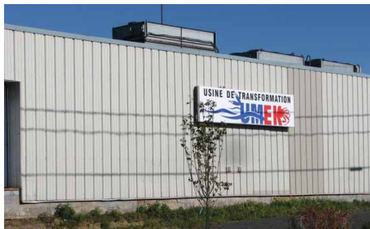
Usine de transformation Umek
